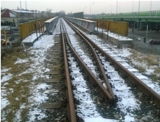
Torowisko łącznicy kolejowej - widok od strony stacji Kabaty w kierunku wiaduktu
