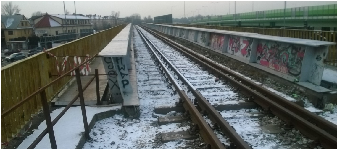
Widok wiaduktu z poziomu torowiska – widok od strony stacji Kabaty
