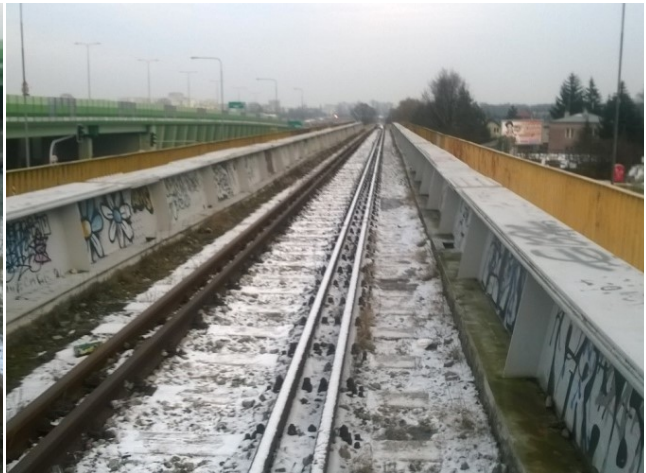
Torowisko łącznicy kolejowej na obiekcie
