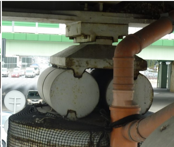
łożyska ruchome na podporach pośrednich
