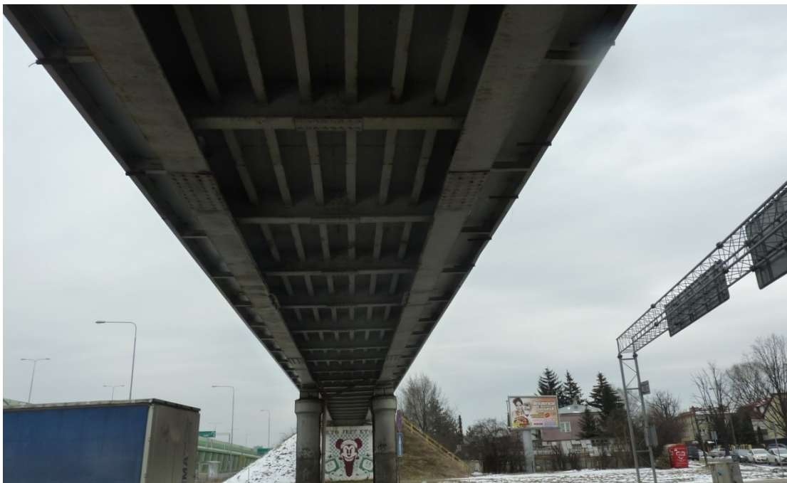
Widok na konstrukcję przęsa wiaduktu od spodu
