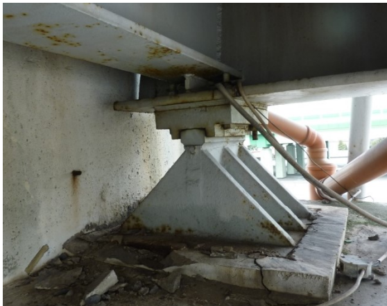
łożyska stałe na przyczółku od strony stacji Okęcie
