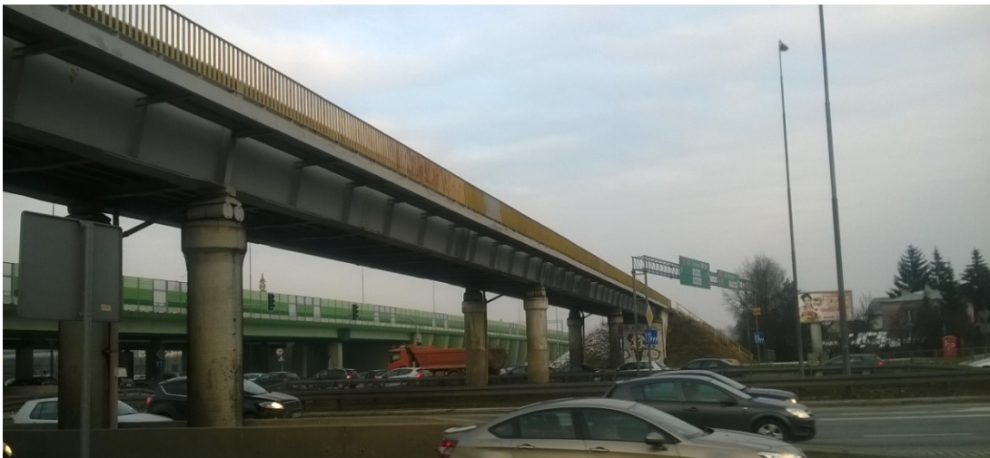
Widok wiaduktu z boku od strony Piaseczna
