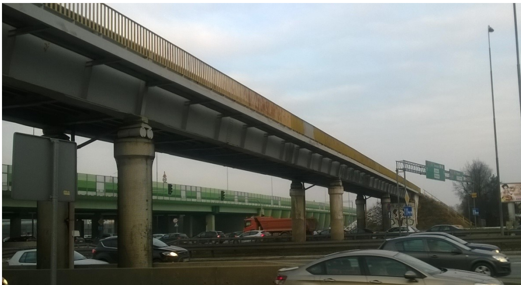
Rys. 1.2 Widok wiaduktu z boku od strony Piaseczna
