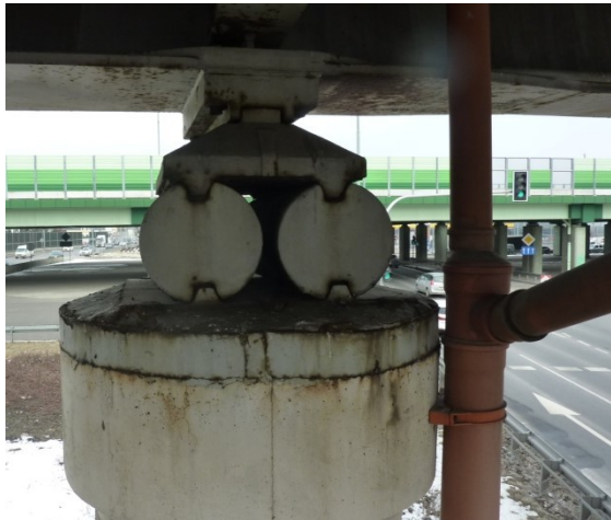
łożyska ruchome na podporach pośrednich
