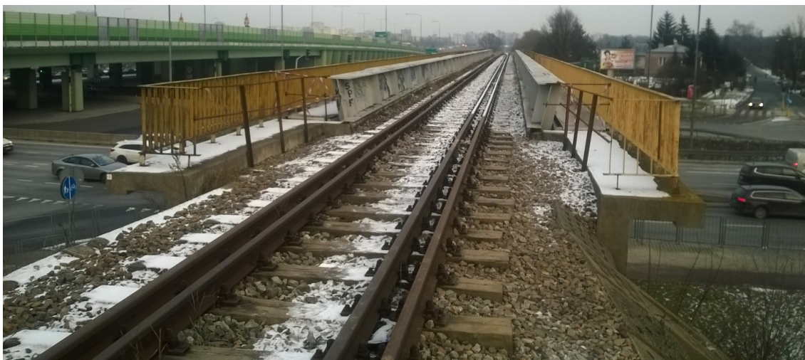
Widok wiaduktu z poziomu torowiska – widok od strony stacji Okęcie
