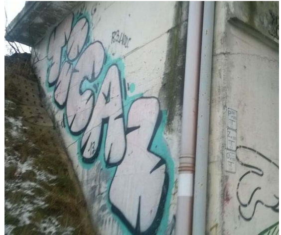
Rury spustowe przy przyczółku od strony stacji Kabaty
