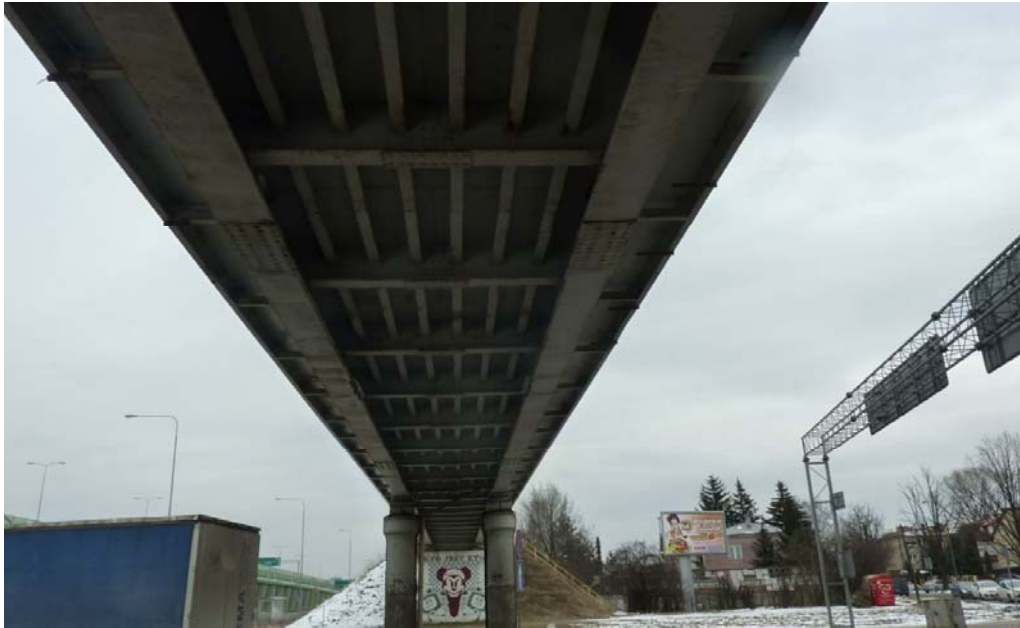
Widok na konstrukcję przęsła wiaduktu od spodu
