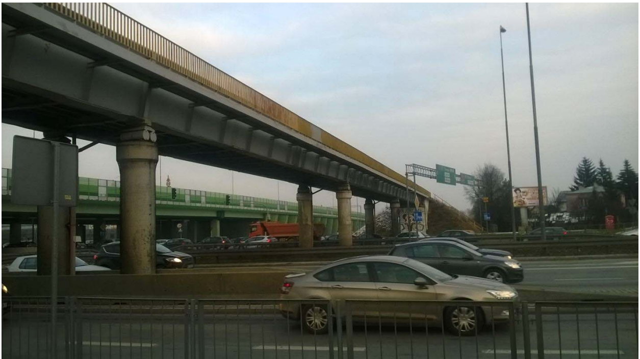
Rys. 1.2 Widok wiaduktu z boku od strony Piaseczna
