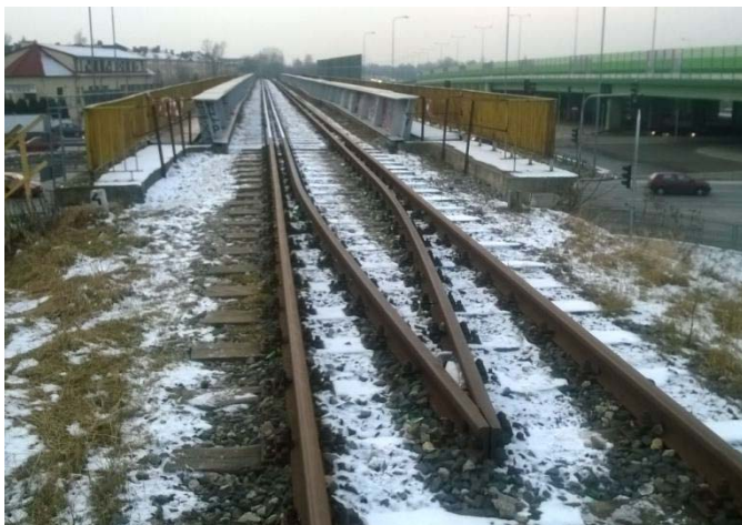
Torowisko łącznicy kolejowej - widok od strony stacji Kabaty w kierunku wiaduktu
