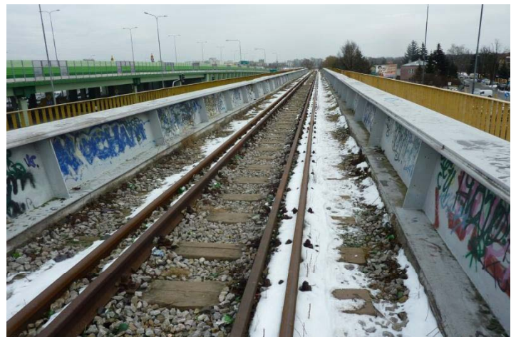
Torowisko łącznicy kolejowej na obiekcie widok od strony stacji Okęcie
