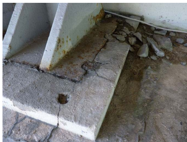
Spękane ciosy podłożyskowe
