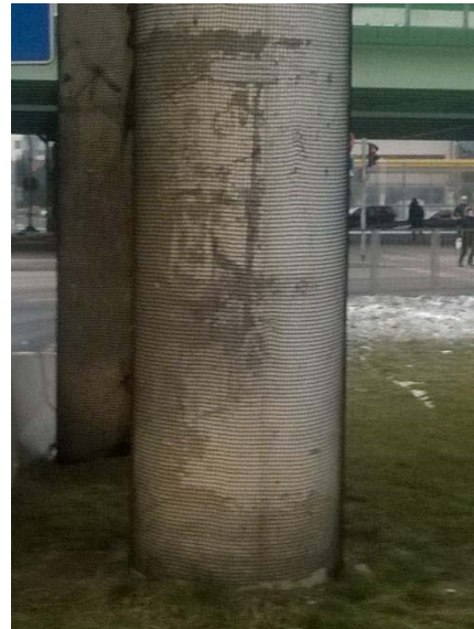
Odspojenia nadlewki i korozja opaski stalowej
