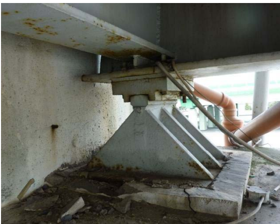
Łożyska stałe na przyczółku od strony stacji Okęcie
