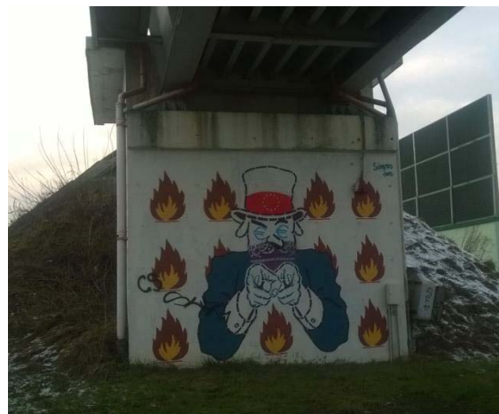
Przyczółek od strony stacji Okęcie
