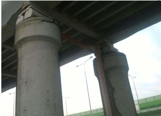
Zabezpieczenie podpór pośrednich skrajnych siatką z tworzywa sztucznego
