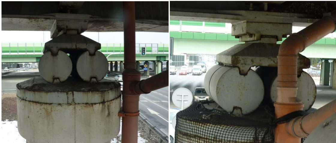
łożyska ruchome na podporach pośrednich
