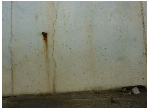
Rysa pionowa ścianki żwirowej w części środkowej
