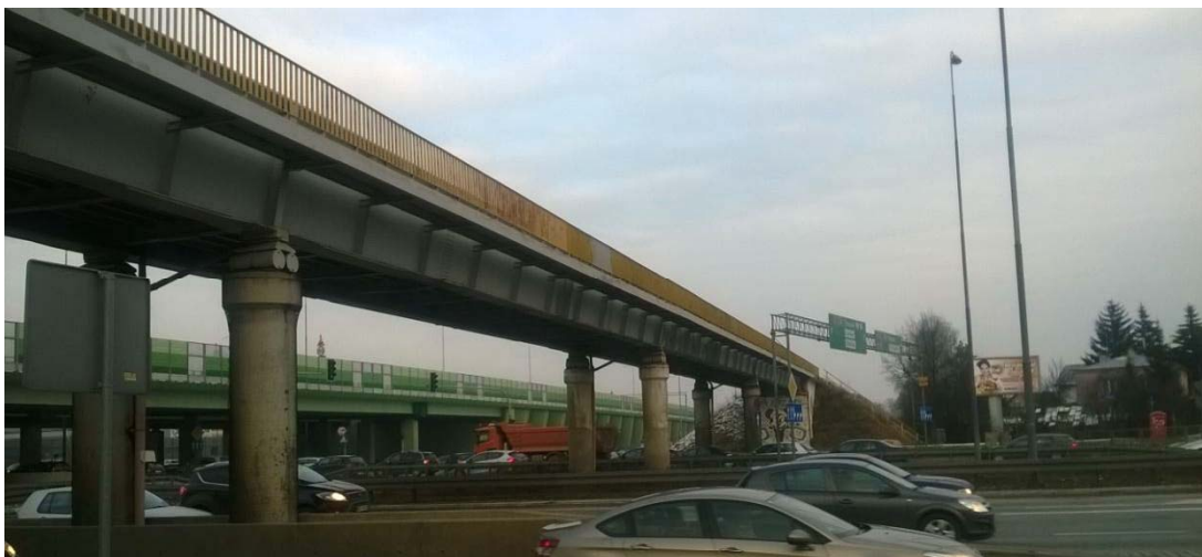
Widok wiaduktu z boku od strony Piaseczna
