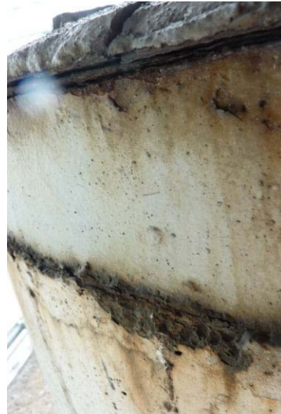
Odspojenia nadlewki i korozja opaski stalowej
