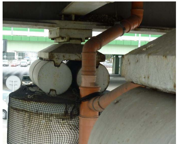
Rury spustowe przy podporach pośrednich
