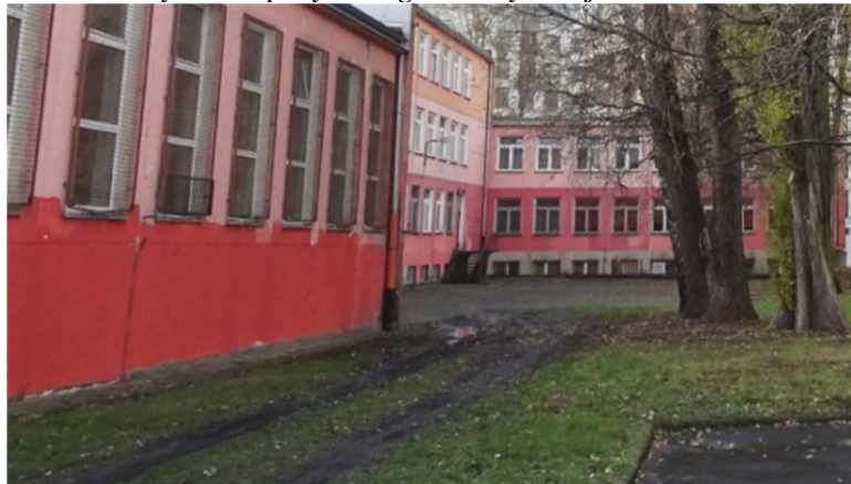
Zdjęcie 8 Nie utwardzony teren przy sali gimnastycznej
