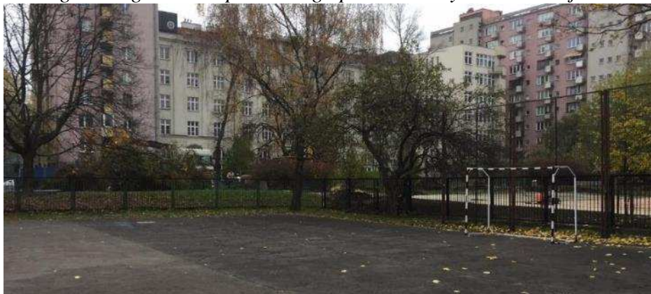
Zdjęcie 13 Fragment ogrodzenia panelowego przeznaczony do likwidacji
