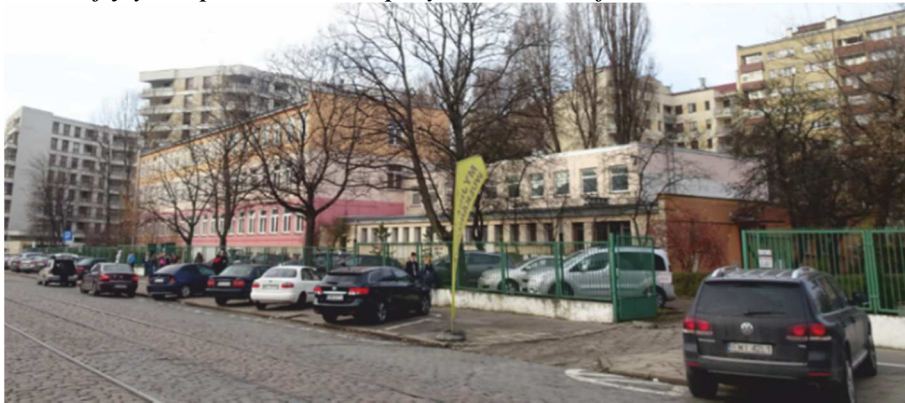
Zdjęcie 2 Istniejący Zespół Szkół nr 7 przy ul. Chłodnej w Warszawie
