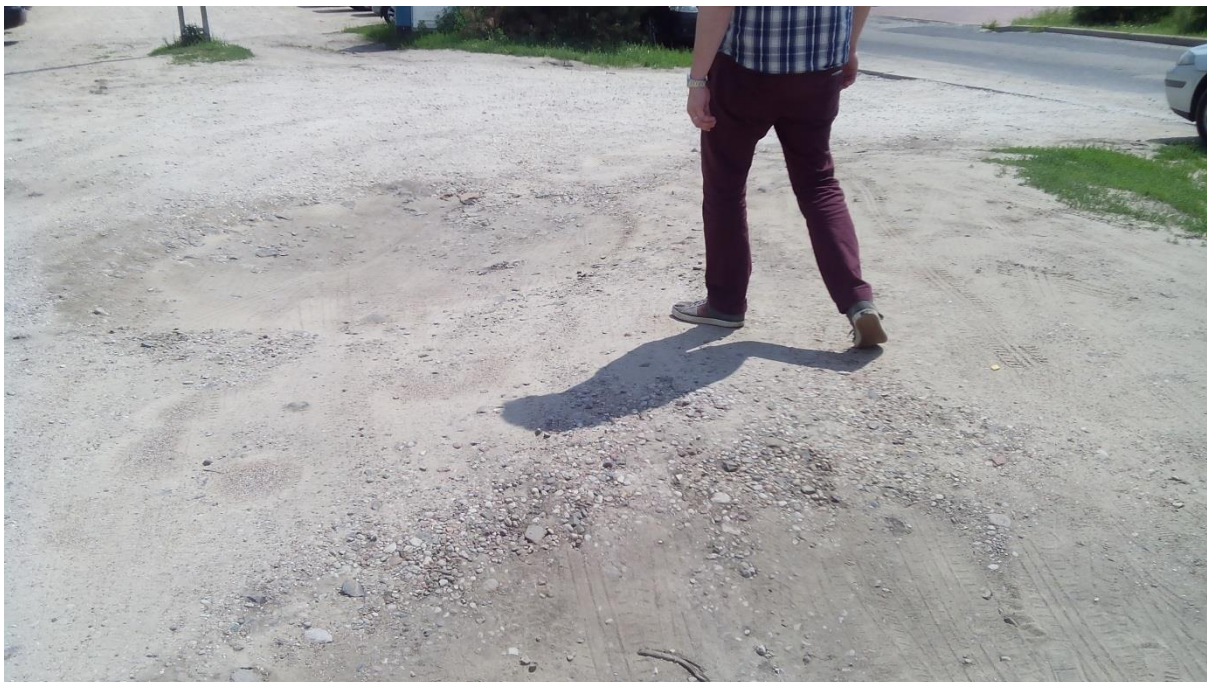
(stan nawierzchni rejonu 2A)
