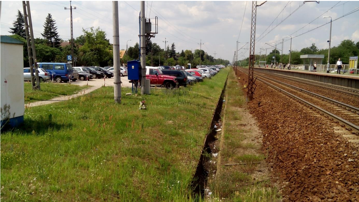
(brak zabezpieczenie pomiędzy rejonami [2A] i [2B], a torowiskiem)
