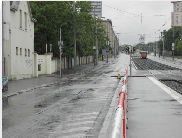
Zawężenie ulicy przy przystanku
